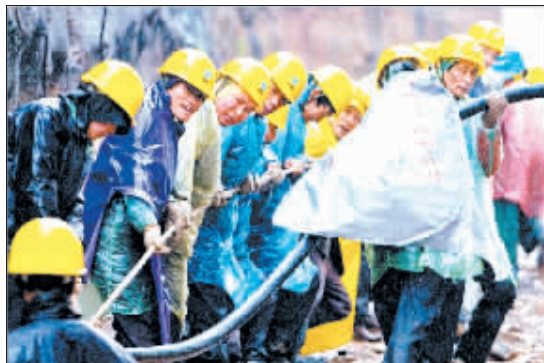
3月5日1版,电力工人寒风中坚守岗位。
